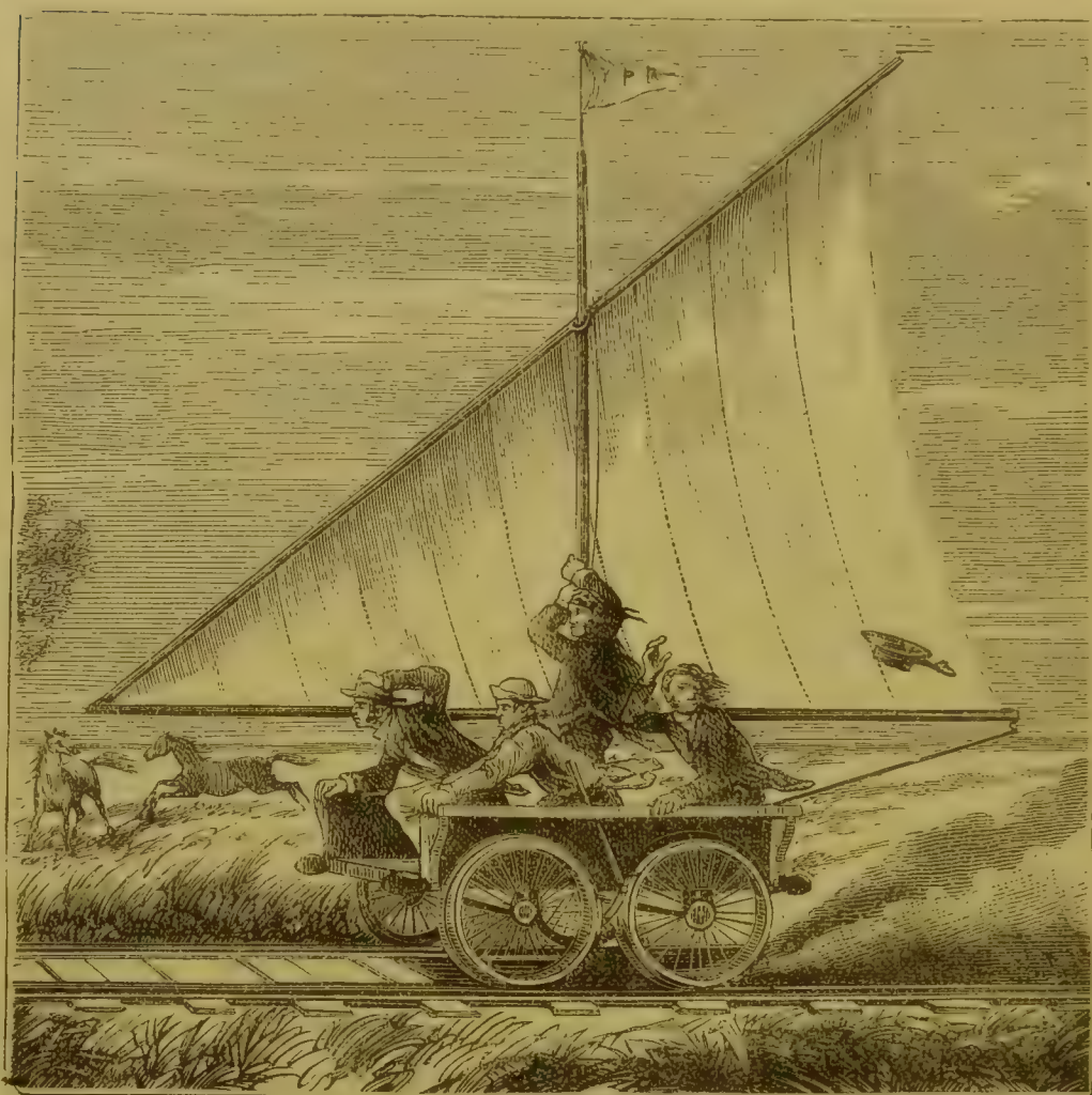
Fig. 277. Vagone a vela usato sulla via del Kansas-Pacifico, agli Stati Uniti.
